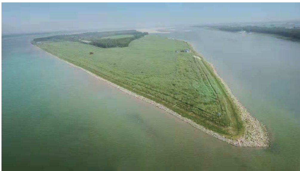
图 荆江工程陡湖堤水道南星洲守护工程
