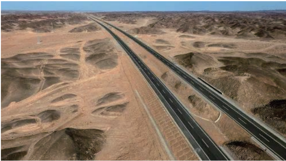
图 穿越沙漠的高速公路——京新高速公路
