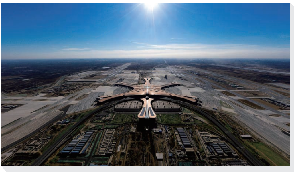
图 北京大兴国际机场
