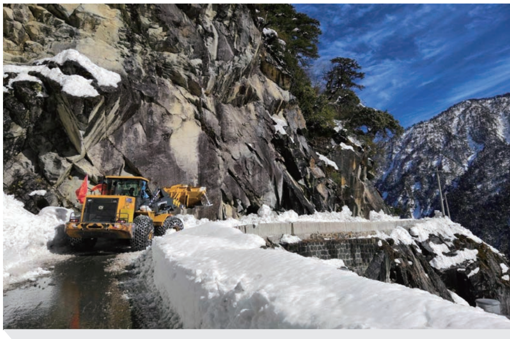
图 实施公路抢通作业
