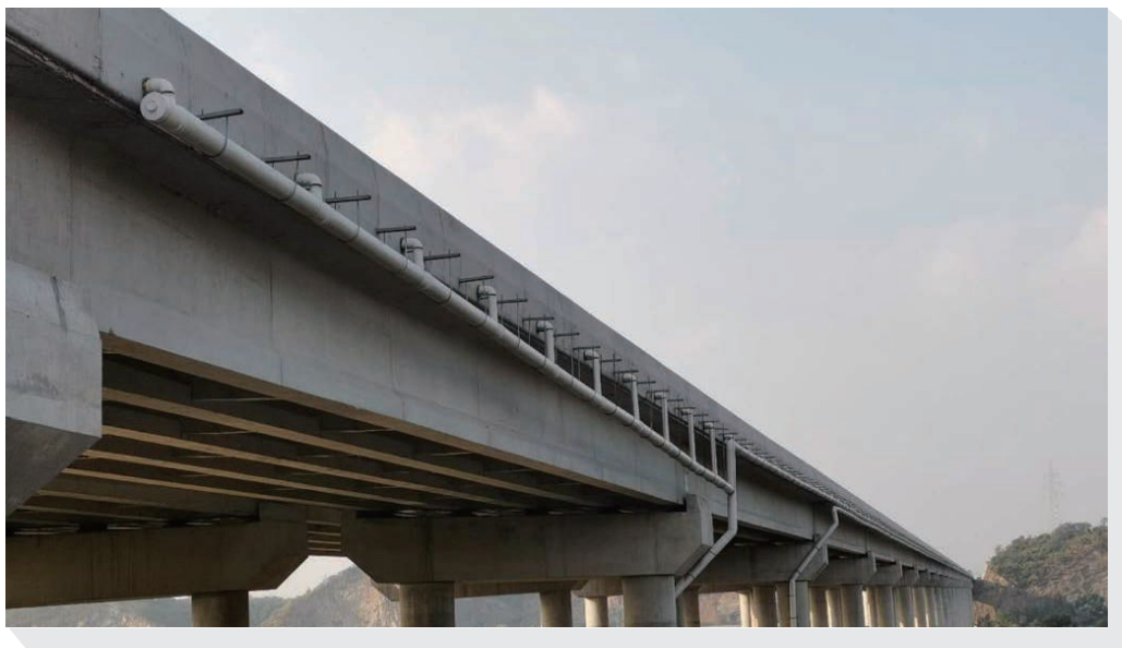
图 桥梁预防性养护增设桥面径流集水系统
