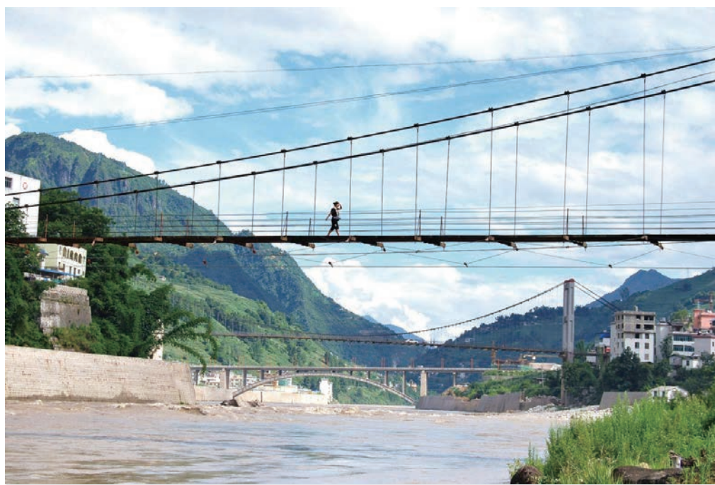
图 云南省福贡县上帕镇替代溜索的跨江大桥
