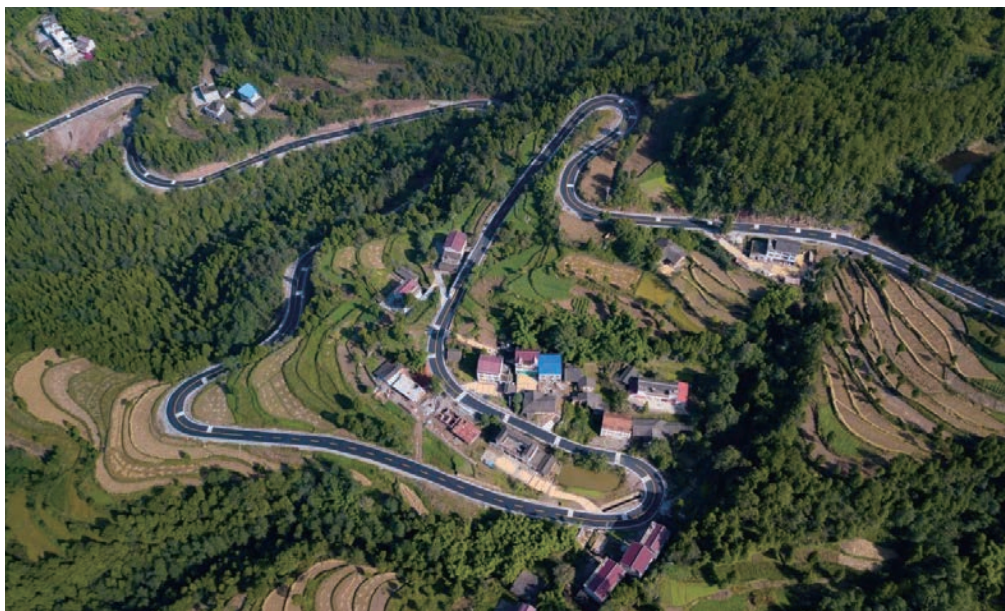
图 四川省苍溪县农村公路
