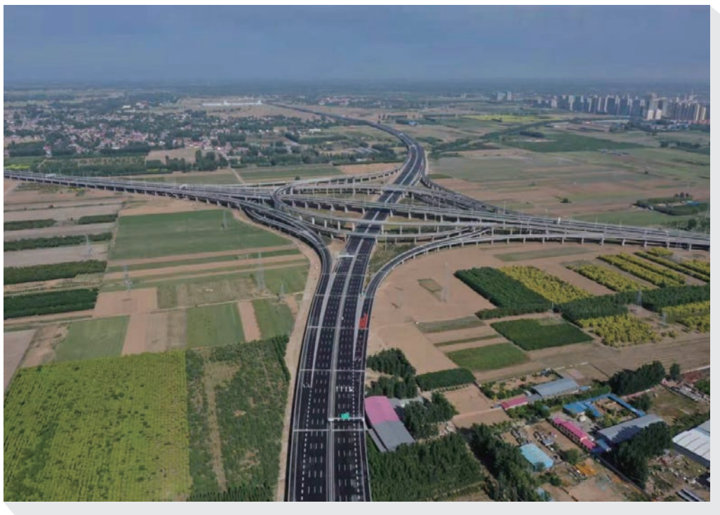
图 京雄高速公路
