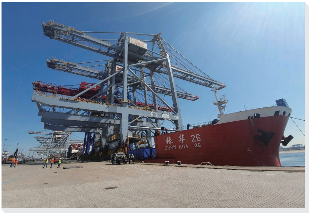
图 振华重工为荷兰鹿特丹港与德国汉堡港建造的岸桥
