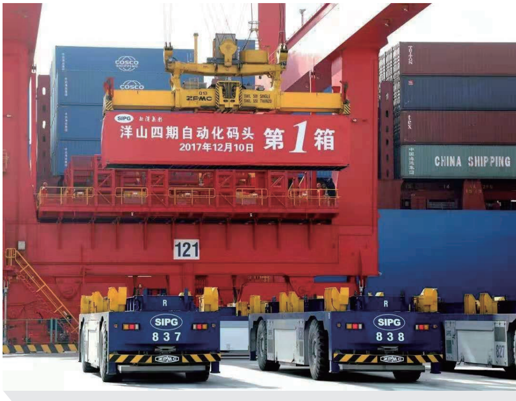
图 上海洋山港四期自动化码头
