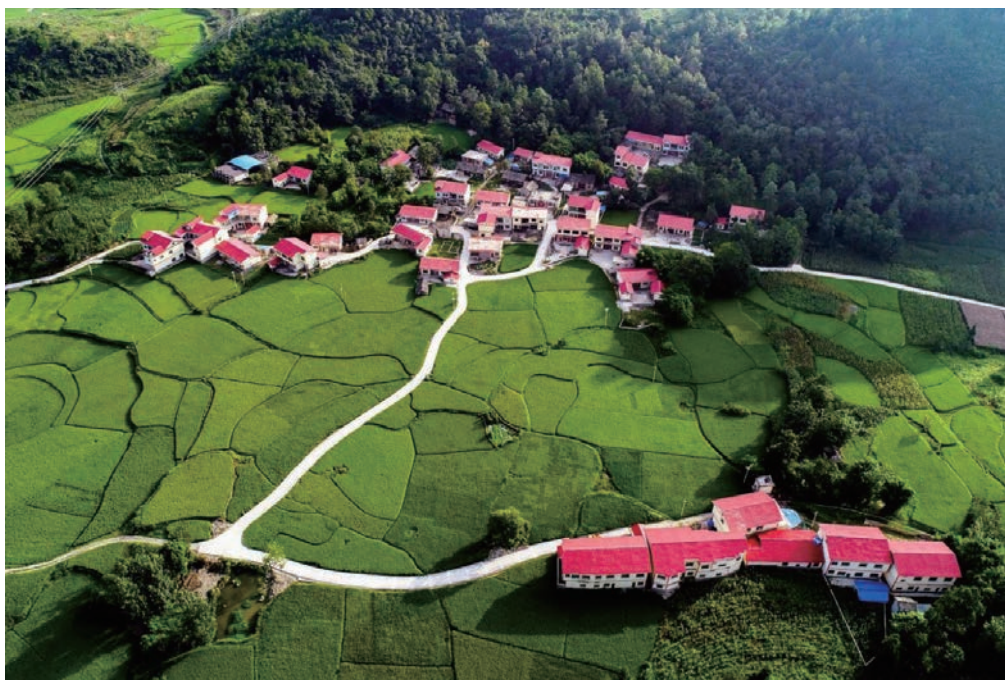
图 贵州省黔南州长顺县农村公路
